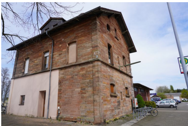
Bahnhofsgebäude in Bruchmühlbach (Dana Taylor, 2020)
