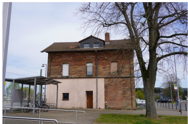
Seitenansicht des Bahnhofsgebäudes in Bruchmühlbach (Dana Taylor, 2020)
