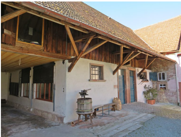
Gebäude des Bachbahnmuseums in Erfenbach (Helge Ebling, 2018)
