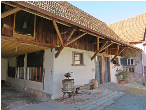
Gebäude des Bachbahnmuseums in Erfenbach (Helge Ebling, 2018)
