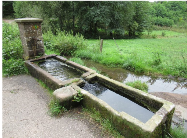
Aufbau mit Abflussrohr, Tröge und Klopstein (Manfred Grad, 2018)
