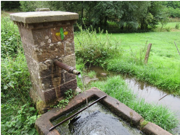
Aufbau mit Abflussrohr (Manfred Grad, 2018)
