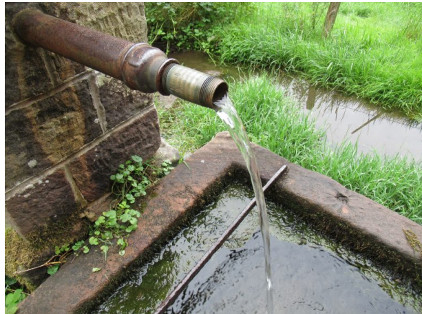
Abflussrohr des Ziegelbrunnens (Manfred Grad, 2018)
