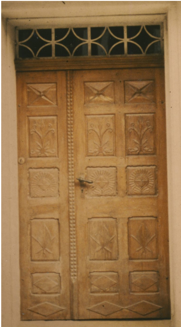
Verziertes Türblatt der Haustür des Dreiseithofs in Hinzweiler (1980)
