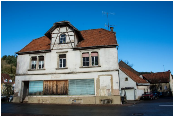
Ehemaliges Gast- und Warenhaus Cappel in Hinzweiler (Sonja Kasprick, 2020)
