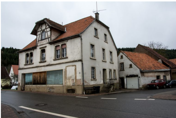
Ehemaliges Gast- und Warenhaus Cappel in Hinzweiler. Im Hintergrund ist der Anbau mit der Unterkunft der Mägde und der Kutsche zu sehen (Sonja Kasprick, 2020)
