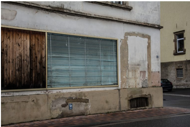
Schaufenster des ehemaligen Gast- und Warenhauses Cappel. Neben dem Schaufenster ist ein zugemauertes bodentiefes Fenster zu erkennen (Sonja Kasprick, 2020)
