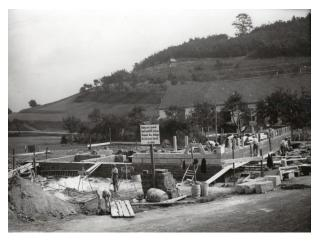
Die schweren Sandsteinblöcke des Kellergeschosses wurden ohne maschinelle Hilfe aufgemauert (Unbekannt, um 1926)
