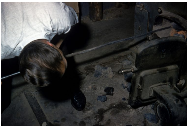
Heizung des Volksbads (Hubert Schneider, 1959)
