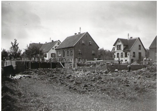
Maurerarbeiten am Kellergeschoss (Unbekannt, um 1926)
