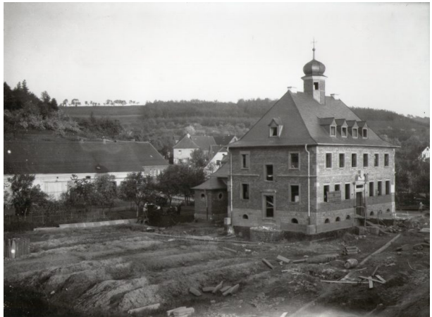
Baufortschritt Frühsommer 1927 (Unbekannt, 1927)
