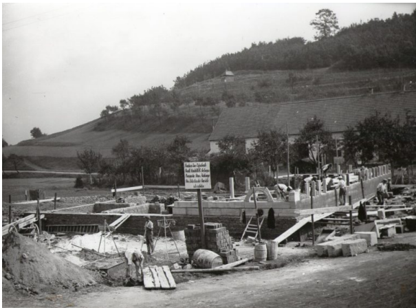
Die schweren Sandsteinblöcke des Kellergeschosses wurden ohne maschinelle Hilfe aufgemauert (Unbekannt, um 1926)
