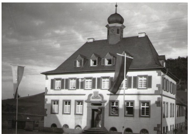
Fertiggestelltes Rathaus (Unbekannt, 1927)
