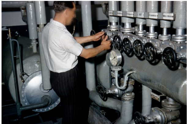
Heizsystem des Volksbads (Hubert Schneider, 1959)
