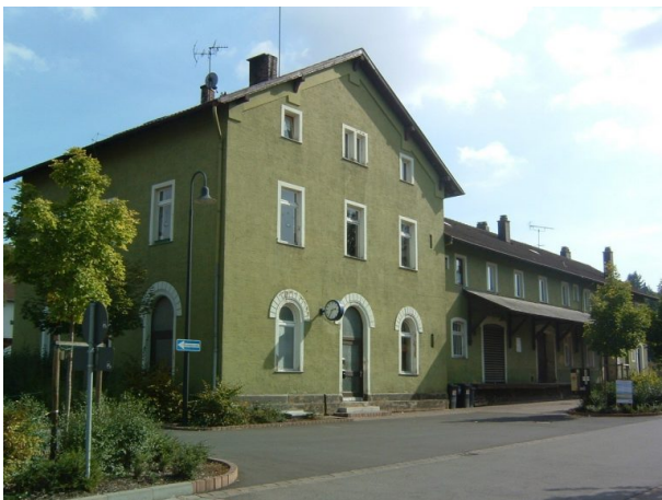
Bahnhofsgebäude mit Lagerhallen in Alsenz (VG Alsenz-Obermoschel, 2008)
