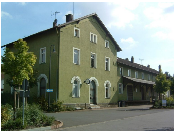
Bahnhofsgebäude mit Lagerhallen in Alsenz (VG Alsenz-Obermoschel, 2008)
