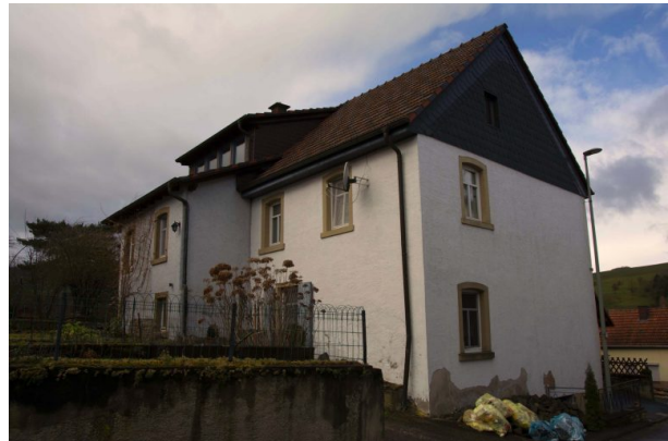
Rückseite der ehemaligen Metzgerei Kleres (Sonja Kasprick, 2020)
