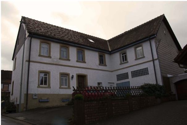
Nordwestansicht der ehemaligen Metzgerei Kleres mit Eingangsbereich (Sonja Kasprick, 2020)
