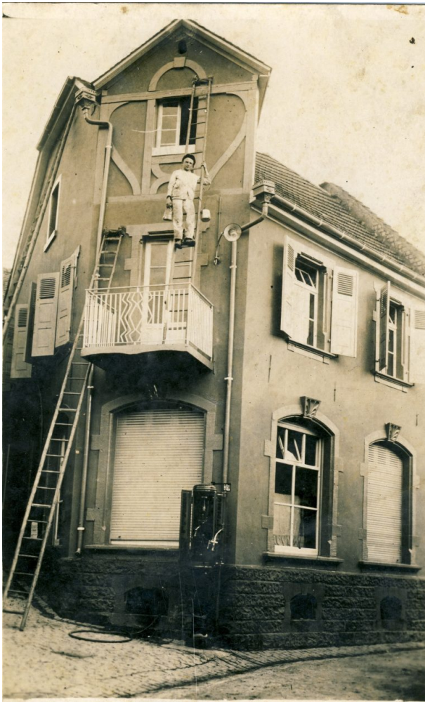
Tankstelle Schmitt (OG Hinzweiler/ Werner Lang, 1936)
