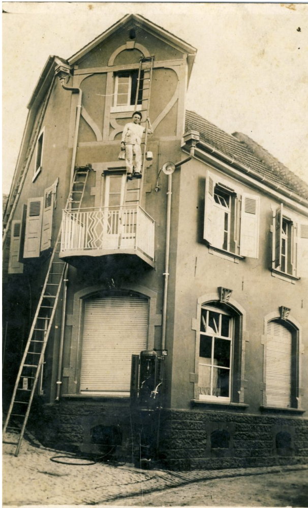
Tankstelle Schmitt (OG Hinzweiler/ Werner Lang, 1936)
