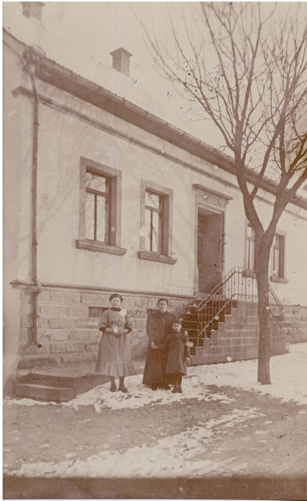
Wohnhaus Mahler in der Hauptstraße 65 in Hinzweiler (OG Hinzweiler/ Werner Lang, 1914)
