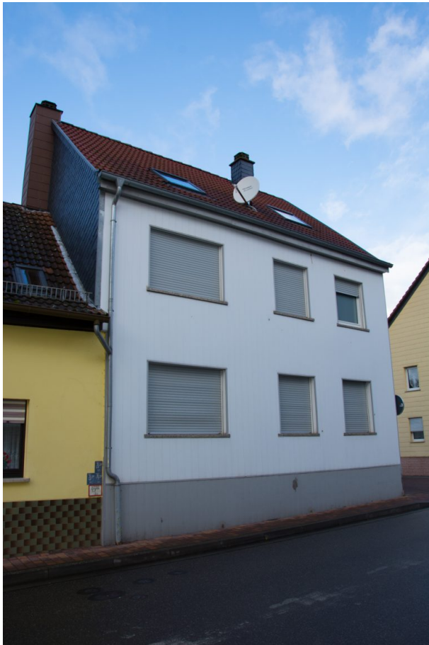
Ehemalige, zum Wohnhaus ausgebaute Scheune des Musikantenhauses (Sonja Kasprick, 2020)
