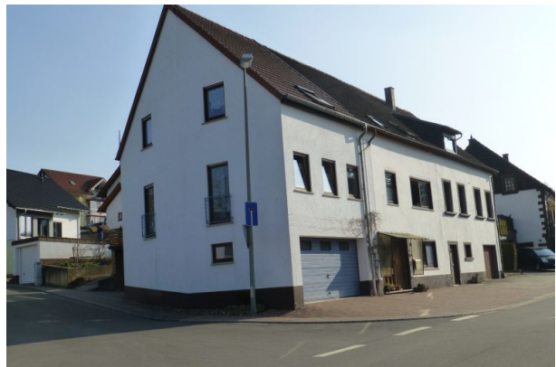
Haus "Nickelpetersch" in der Hauptstraße 5 in Hinzweiler - Nordansicht (OG Hinzweiler/ Werner Lang)
