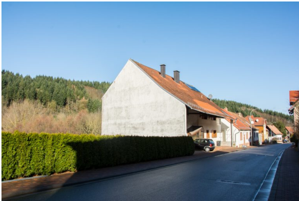
Ehemalige Scheune und dahinter liegendes Wohnhaus in der Hauptstraße 12 in Hinzweiler (Sonja Kasprick, 2020)
