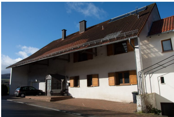
Ehemalige Scheune des Bauernhauses in der Hauptstraße 12 in Hinzweiler (Sonja Kasprick, 2020)
