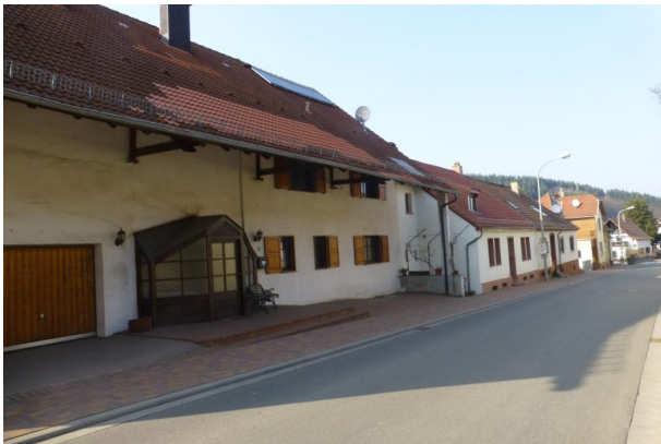
Ehemalige Scheune des Bauernhauses in der Hauptstraße 12 in Hinzweiler (OG Hinzweiler/ Werner Lang, 2013)
