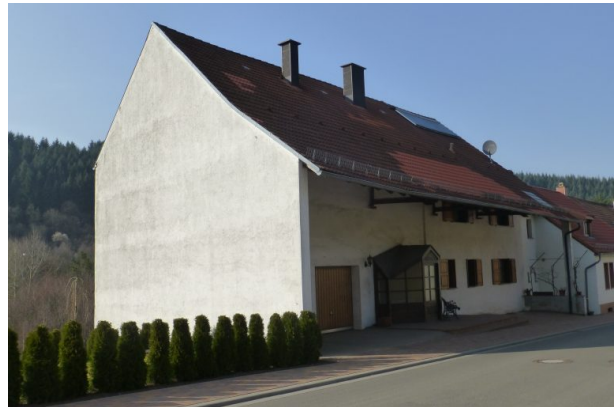
Ehemalige Scheune des Bauernhauses in der Hauptstraße 12 in Hinzweiler (OG Hinzweiler/ Werner Lang, 2014)
