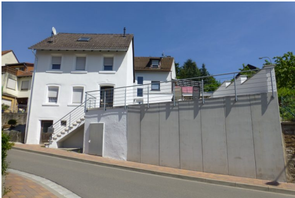
Ehemaliges Musikantenhaus mit neugestaltetem Außenbereich von der Hauptstraße (OG Hinzweiler/ Werner Lang, 2015)
