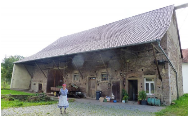
Links Stall und Scheune und rechts die "alte" Wohnung" (OG Hinzweiler/ Werner Lang, 2015)
