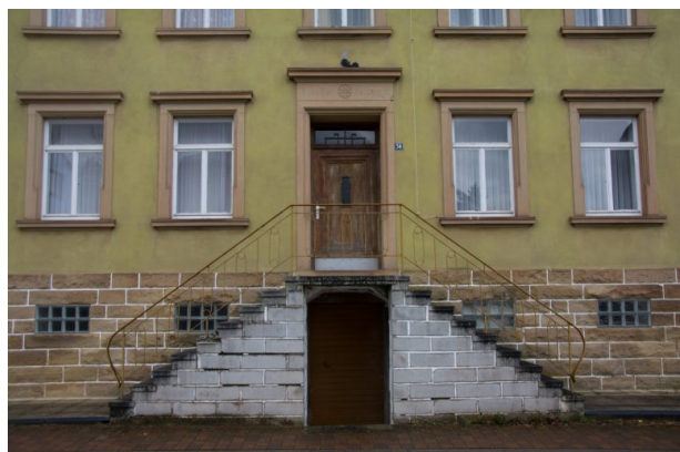
Treppenaufgang zum Bauernhaus Biehl (Sonja Kasprick, 2020)
