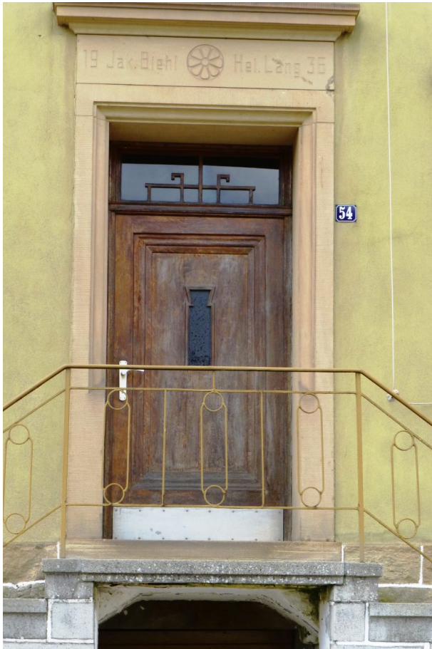
Eingangstür mit Türinschrift des "neuen" Hauses (OG Hinzweiler/ Werner Lang, 2014)
