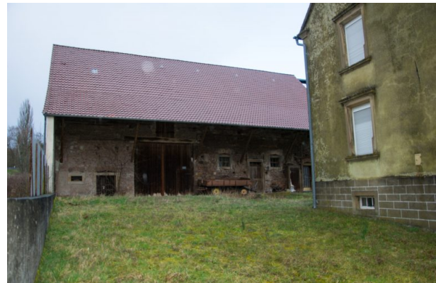
Im Hintergrund die "alte Wohnung" mit Stall und Scheune. Am rechten Bildrand das "neue" Wohnhaus (Sonja Kasprick, 2020)
