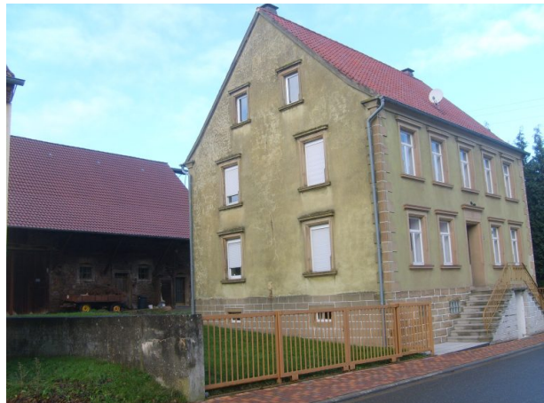
Im Vordergrund das Bauernhaus Biehl. Im Hintergrund die "alte Wohnung" mit Stall und Scheune (OG Hinzweiler/ Werner Lang, 2014)
