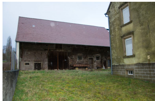
Im Hintergrund die "alte Wohnung" mit Stall und Scheune. Am rechten Bildrand das "neue" Wohnhaus (Sonja Kasprick, 2020)
