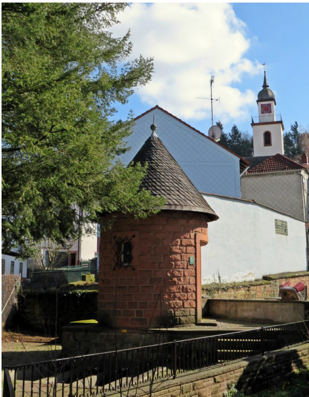
Röhrenbrunnen in Erfenbach (Helge Ebling, 2018)
