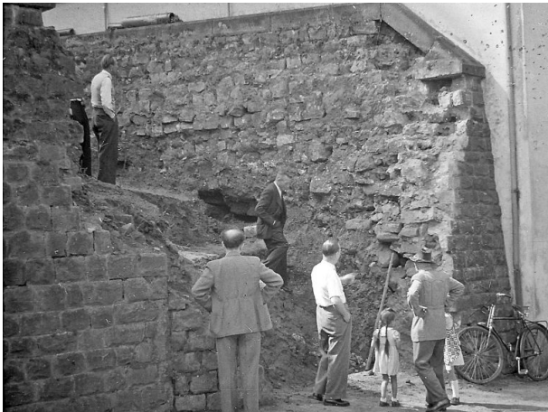
Protestantische Kirche - Ausschachtarbeiten neuer Treppenaufgang (unbekannt, 1953)
