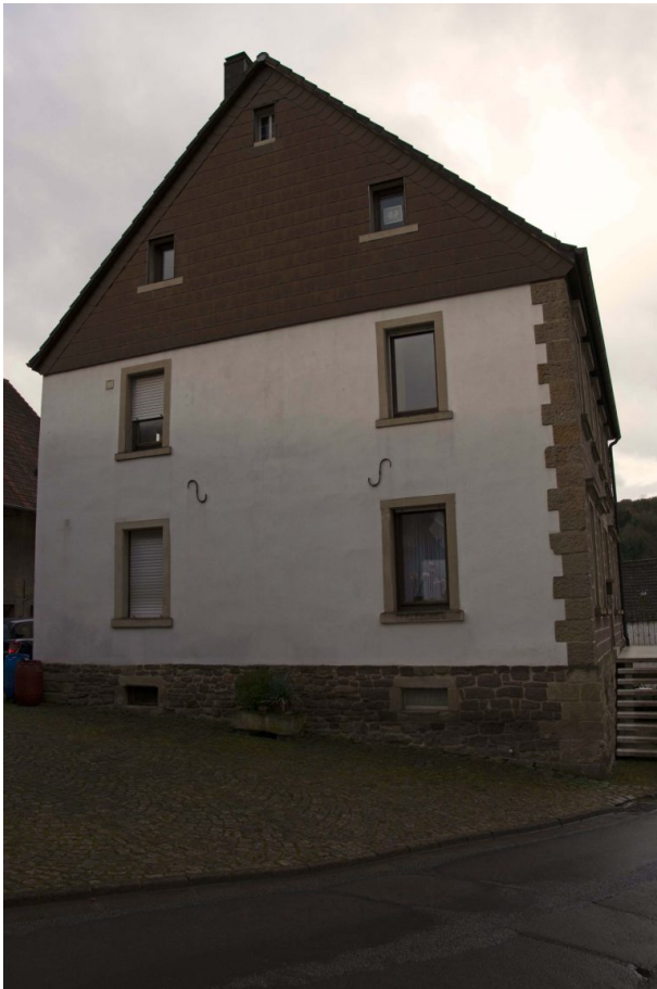
Ehemaliges Bauernhaus Biehl im Oberdorf 8 in Hinzweiler - Seitenansicht (Sonja Kasprick, 2020)
