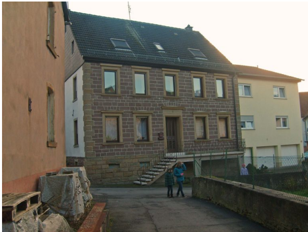
Ehemaliges Bauernhaus Biehl im Oberdorf 8 in Hinzweiler (OG Hinzweiler/ Werner Lang, 2013)
