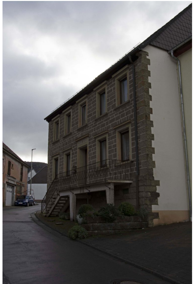
Ehemaliges Bauernhaus Biehl im Oberdorf 8 in Hinzweiler (Sonja Kasprick, 2020)
