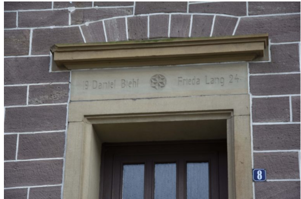
Türinschrift des ehemaligen Bauernhauses Biehl (Sonja Kasprick, 2020)
