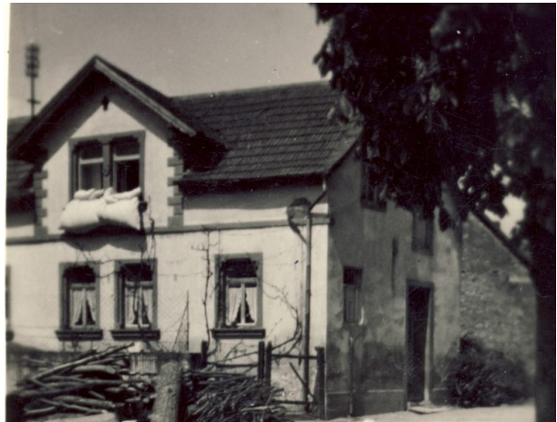
Ehemaliges Musikantenhaus in Hinzweiler (OG Hinzweiler/ Werner Lang, 1952)
