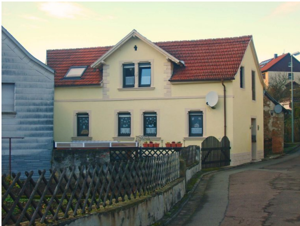
Ehemaliges Musikantenhaus in Hinzweiler (OG Hinzweiler/ Werner Lang, 2014)
