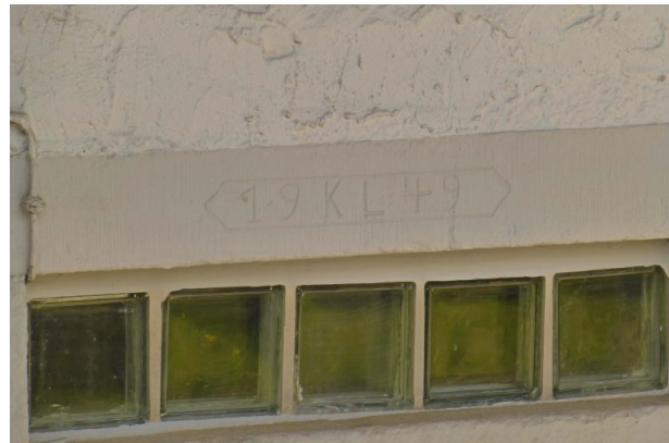
Türinschrift am Eingang zur Scheune (OG Hinzweiler/ Werner Lang)
