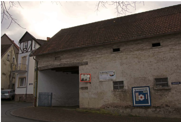
Rückseite der Scheune von der Hauptstraße aus betrachtet (Sonja Kasprick, 2020)
