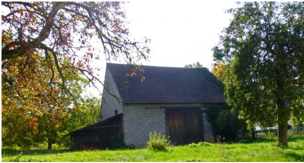
In den 1960er Jahren ergänzter Anbau (OG Hinzweiler/ Werner Lang)
