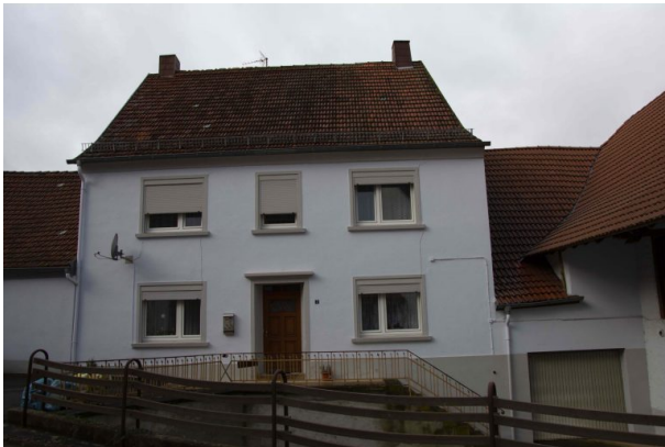
Wohnhaus des ehemaligen landwirtschaftlichen Betriebs (Sonja Kasprick, 2020)
