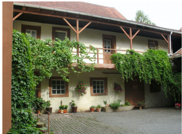
Wirtschaftsgebäude angrenzend an das Wohnhaus (OG Hinzweiler/ Werner Lang, 2014)
