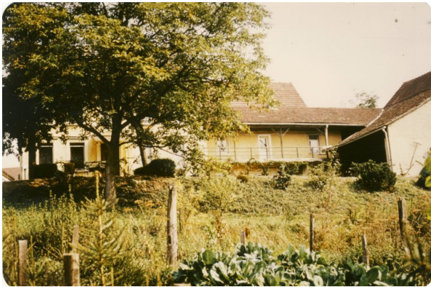
Ansicht von Westen auf die Gebäude (OG Hinzweiler/ Werner Lang, 1985)
