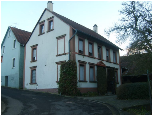
Wohnhaus - Straßenansicht (OG Hinzweiler/ Werner Lang, 2013)
