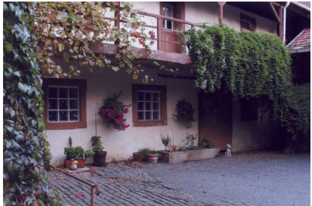
Wirtschaftsgebäude angrenzend an das Wohnhaus (OG Hinzweiler/ Werner Lang, 2014)
