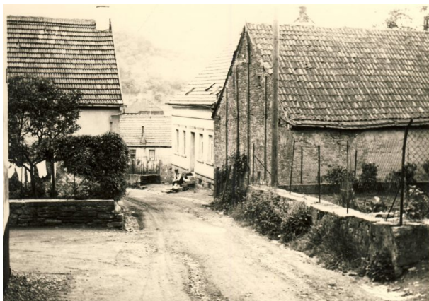
Blick in die Straße Mühlberg. Im Hintergrund ist das Musikantenhaus Waldersch zu erkennen (OG Hinzweiler/Werner Lang, o. J.)
