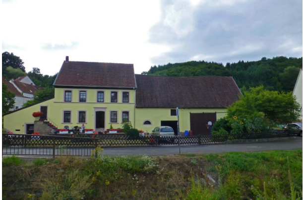
Bauernhaus In der Au 1 Straßenansicht (OG Hinzweiler/ Werner Lang, 2015)
