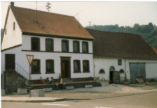
Bauernhaus In der Au 1 in den 1980er Jahren (OG Hinzweiler/ Werner Lang, 1982)
