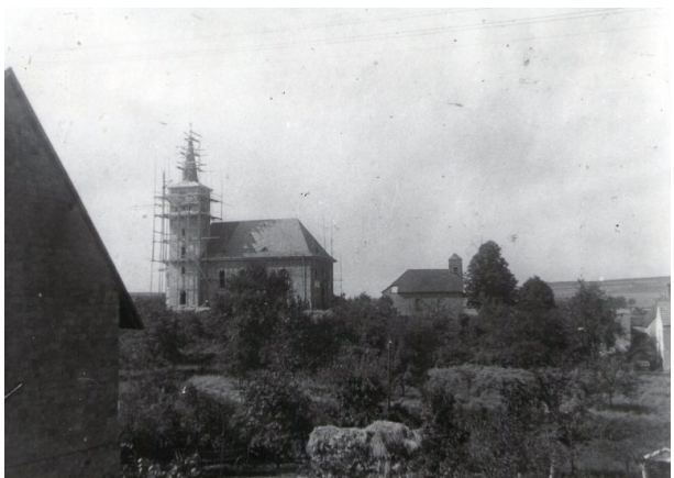
Katholische Kirche - kurz vor der Fertigstellung (unbekannt, 1927)
