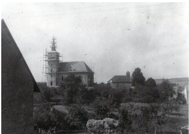
Katholische Kirche - kurz vor der Fertigstellung (unbekannt, 1927)
