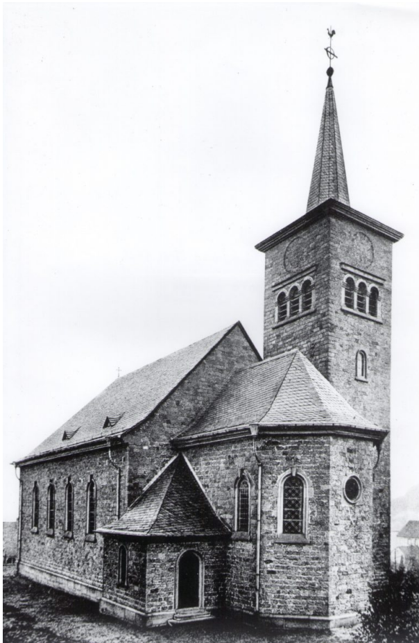
Fertiggestellte katholische Kirche. Hier noch der Kirchturm mit Spitzhelm (unbekannt, 1927)
