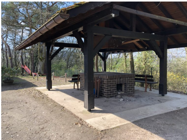
Grillplatz an der PWV-Hütte Olsbrücken (Dana Taylor, 2020)
