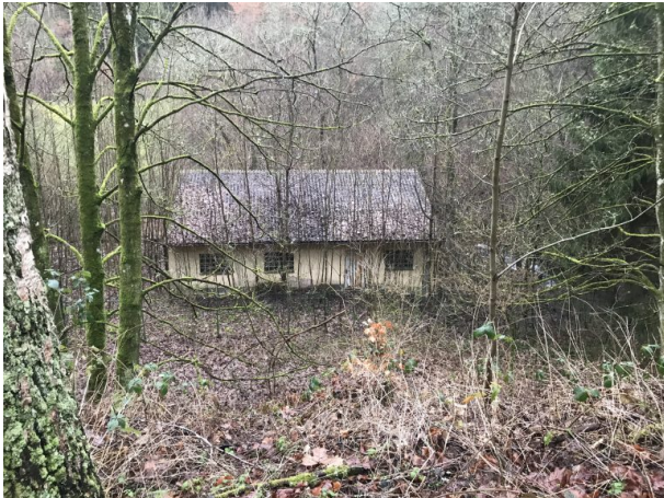
Altes Pumpwerk am Oberhammer (Marcel Krupka, 2020)
