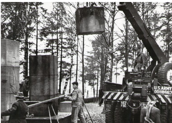
Bauarbeiten zur Ergänzung des Denkmals (unbekannt, 1962)
