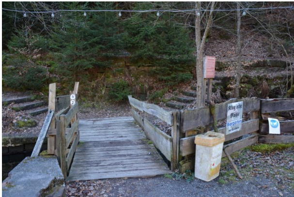
Brücke über die Moosalbe (Sonja Kasprick, 2019)
