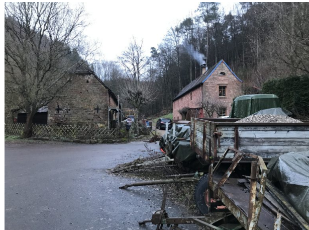
Weitere Gebäude an der Eisenschmelz (Marcel Krupka, 2020)
