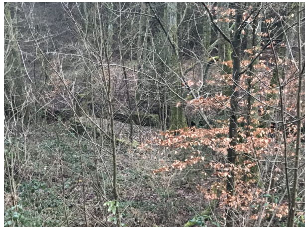
Stauwehr Blechwalzwerk - Schlecht zugänglich (Marcel Krupka, 2020)
