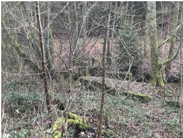
Stauwehr Blechwalzwerk - Schlecht zugänglich (Marcel Krupka, 2020)
