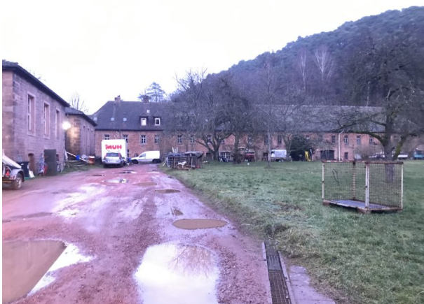
Hof des Blechwalzwerks (Marcel Krupka, 2020)
