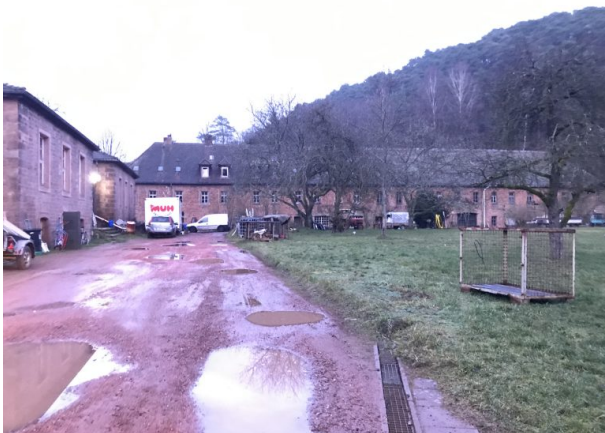
Hof des Blechwalzwerks (Marcel Krupka, 2020)
