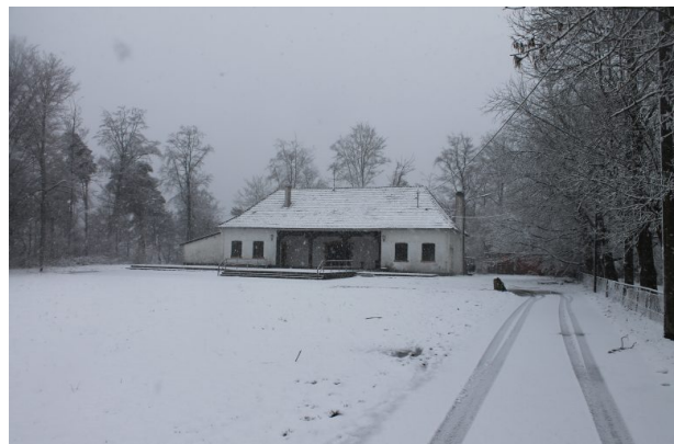
Heidenkopfhalle mit davor angrenzender Rasenfläche im Winter (Marcel Krupka, 2020)
