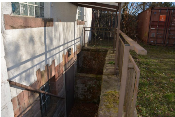
Treppenabgang der Heidenkopfhalle (Sonja Kasprick, 2019)
