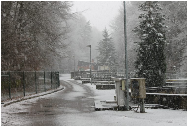
Kläranlage im Kaltenborner Tal (Marcel Krupka, 2020)
