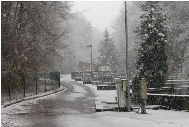
Kläranlage im Kaltenborner Tal (Marcel Krupka, 2020)
