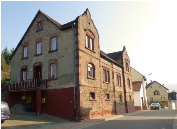
Ehemaliges Musikantenhaus Hubrich. Blick auf die Ecke der Hausnummer 19 (OG Hinzweiler/ Werner Lang, 2014)
