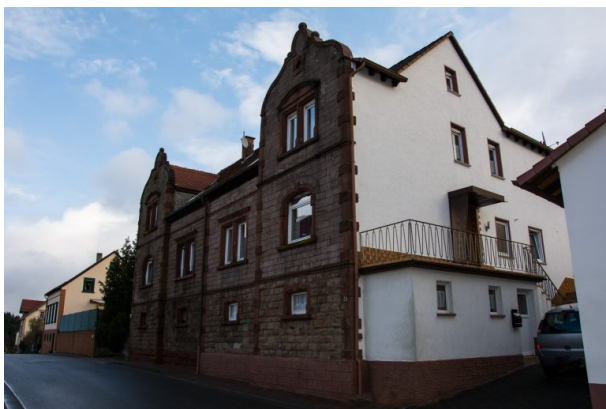
Ehemaliges Musikantenhaus Hubrich. Blick auf die Ecke der Hausnummer 21 (Sonja Kasprick, 2020)
