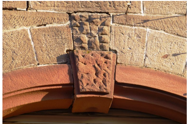
Schlussstein in einem Fensterrahmen des Musikantenhauses (OG Hinzweiler/ Werner Lang, 2014)
