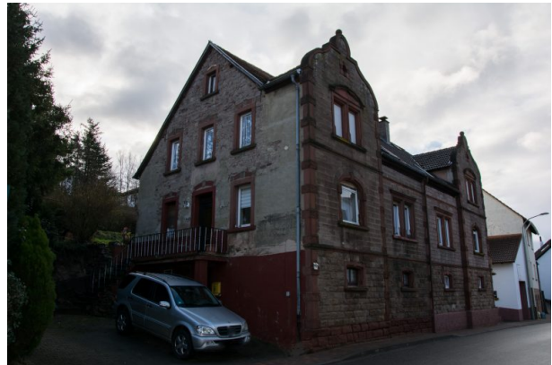
Ehemaliges Musikantenhaus Hubrich. Blick auf die Ecke der Hausnummer 19 (Sonja Kasprick, 2020)
