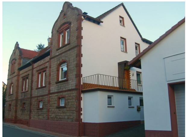
Ehemaliges Musikantenhaus Hubrich. Blick auf die Ecke der Hausnummer 21 (OG Hinzweiler/ Werner Lang, 2014)
