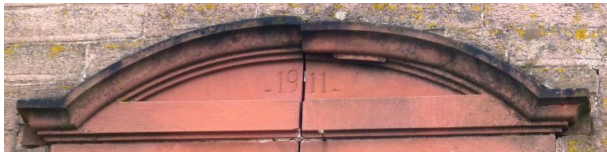
Eingemeißeltes Erbauungsjahr im Fenstergiebel des Musikantenhauses in der Hauptstraße 19 (OG Hinzweiler/ Werner Lang, 2014)
