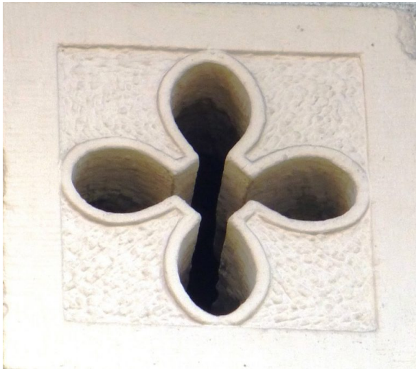
Schmuck der Fassade im Musikantengiebel (OG Hinzweiler/ Werner Lang, 2014)
