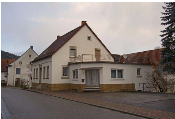
Wohnhaus mit angebautem Verkaufsraum in der Hauptstraße 49 in Hinzweiler (Sonja Kasprick, 2020)
