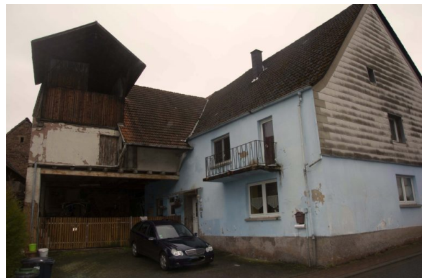
Ehemaliges Bauernhaus Luije Hauptstraße 43 in Hinzweiler (Sonja Kasprick, 2020)
