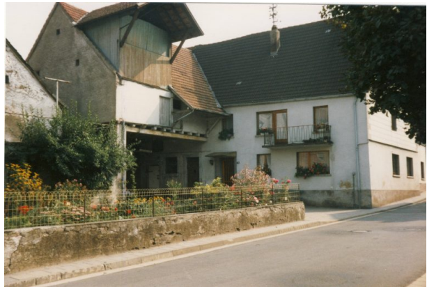
Ehemaliges Bauernhaus Luije Hauptstraße 43 in Hinzweiler (OG Hinzweiler/ Werner Lang, 1980)
