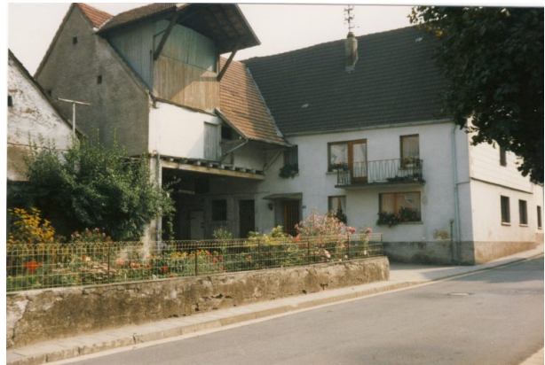
Ehemaliges Bauernhaus Lujje Hauptstraße 43 in Hinzweiler (OG Hinzweiler/ Werner Lang, 1980)
