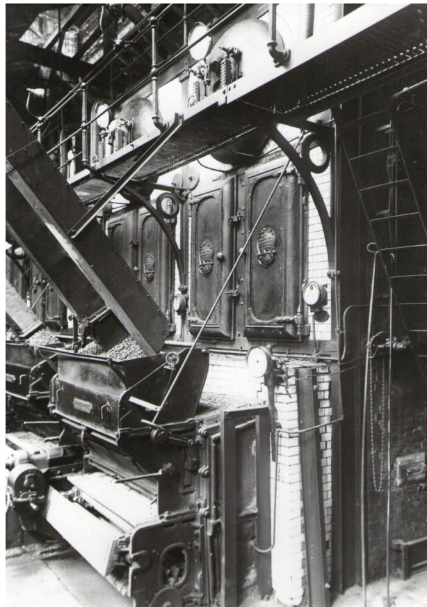
Spinnerei Lampertsmühle - Kesselhaus (unbekannt, um 1920)
