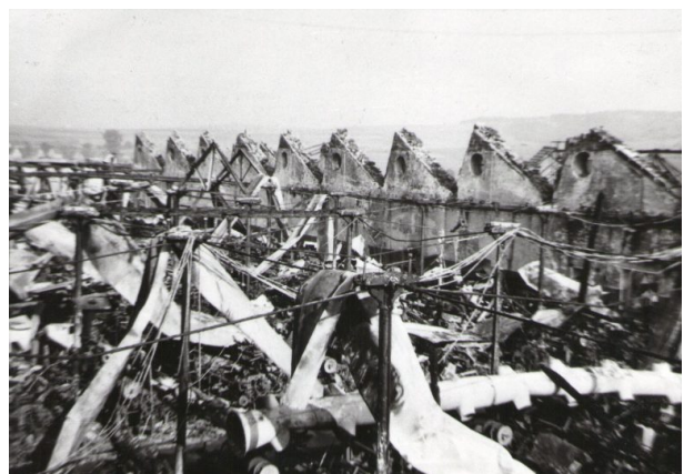
Spinnerei Lampertsmühle - zerstörte Fabrik (unbekannt, 1944)
