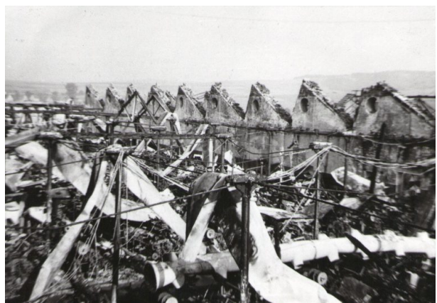
Spinnerei Lampertsmühle - zerstörte Fabrik (unbekannt, 1944)
