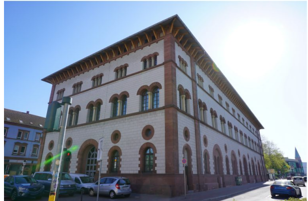
Ansicht von der Martin-Luther-Straße auf die Fruchthalle (Dana Taylor, 2020)
