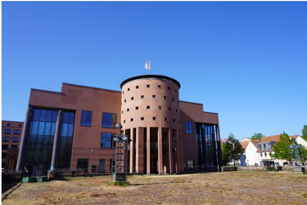
Frontansicht des Pfalztheaters (Dana Taylor, 2020)
