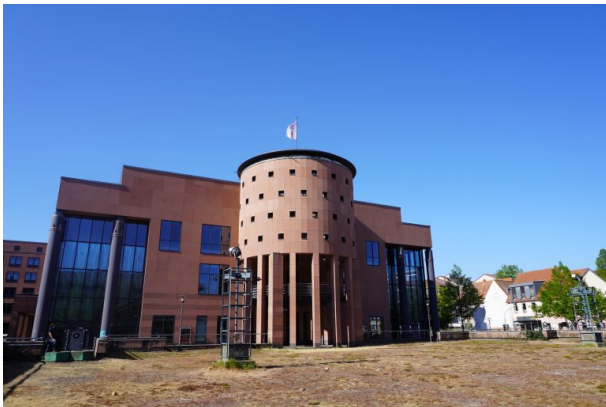
Frontansicht des Pfalztheaters (Dana Taylor, 2020)
