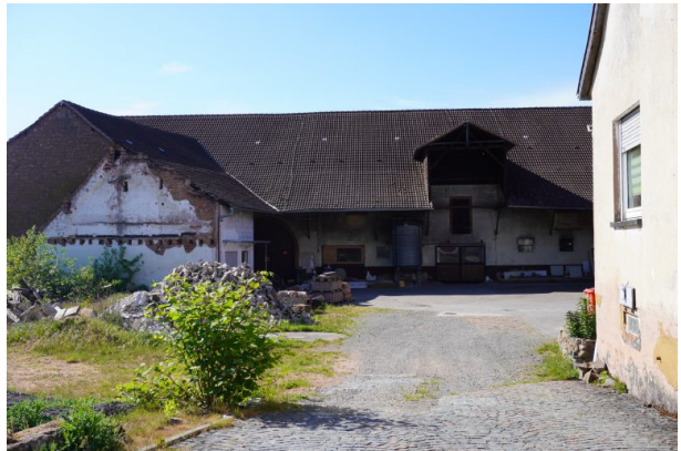
Schanzermühle Gemeinde Bruchmühlbach-Miesau (Dana Taylor, 2020)
