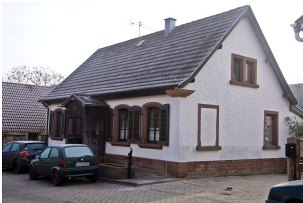
Altes Schulhaus in Stockborn (Helge Ebling, 2015)
