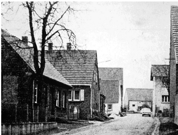
Altes Schulhaus - Links im Bild (unbekannt - Ebling zur Verfügung, um 1950)
