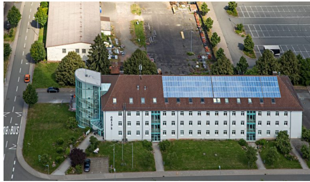
Umgewandeltes Kasernengebäude in ein Bürogebäude für Existenzgründer (Harald Kröher , 2018)
