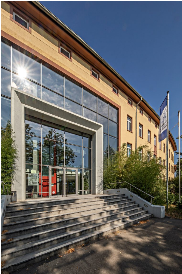
Neuer Haupteingang des "Banana"-Gebäudes (Harald Kröher , 2018)
