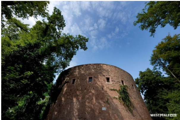
Batterieturm der Burg Nanstein (VG Landstuhl, 2017)
