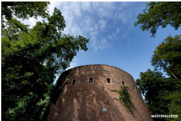
Batterieturm der Burg Nanstein (VG Landstuhl, 2017)
