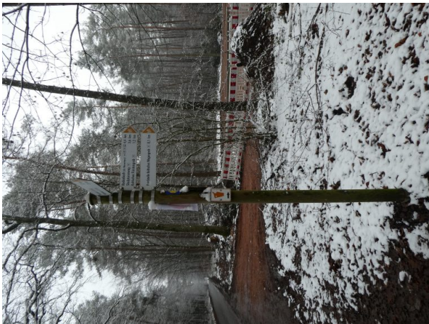
Baustelle "Wagengrab" an der Altstraße bei Schellenbergerhof (J.H.WOLFF, 2021)
