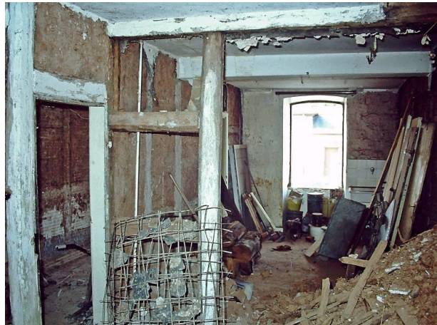
Bauernhaus Erfenbach vor Restaurierung - Innenräume (Edmund Jung, 1993)
