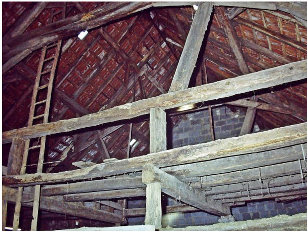
Bauernhaus Erfenbach vor Restaurierung - Innenräume (Edmund Jung, 1993)
