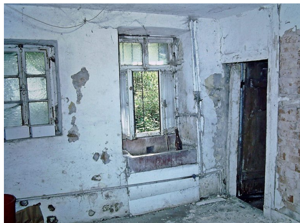
Bauernhaus Erfenbach vor Restaurierung - Innenräume (Edmund Jung, 1993)
