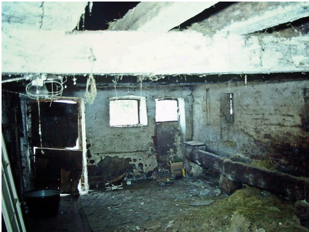
Bauernhaus Erfenbach vor Restaurierung - Innenräume (Edmund Jung, 1993)
