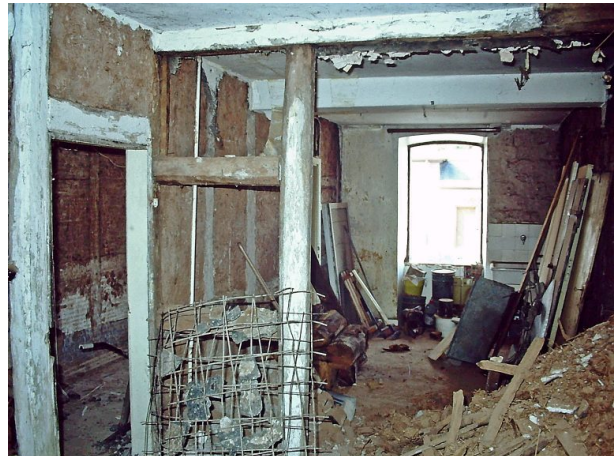
Bauernhaus Erfenbach vor Restaurierung - Innenräume (Edmund Jung, 1993)
