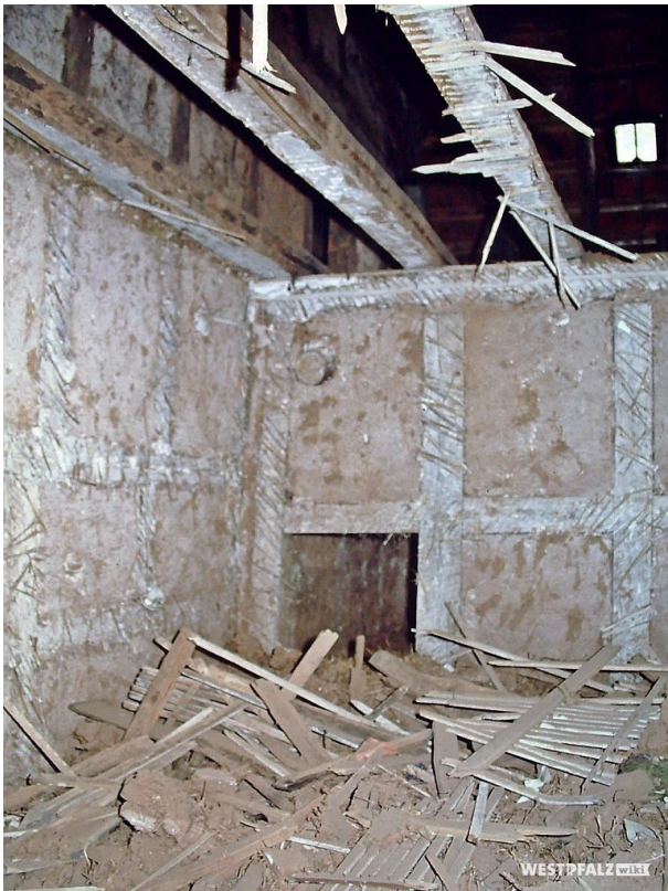
Bauernhaus Erfenbach vor Restaurierung - Innenräume (Edmund Jung, 1993)
