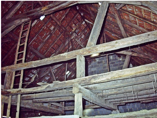
Bauernhaus Erfenbach vor Restaurierung - Innenräume (Edmund Jung, 1993)
