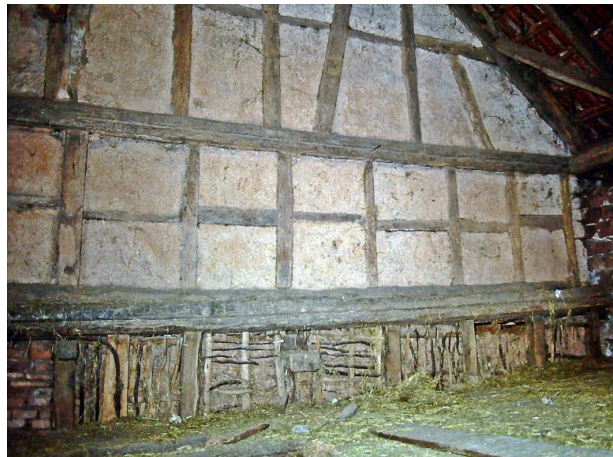
Bauernhaus Erfenbach vor Restaurierung - Innenräume (Edmund Jung, 1993)
