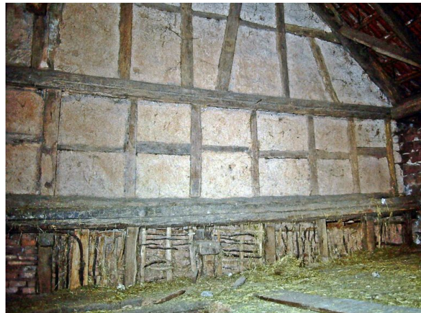
Bauernhaus Erfenbach vor Restaurierung - Innenräume (Edmund Jung, 1993)
