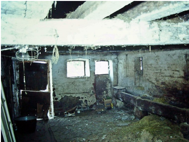
Bauernhaus Erfenbach vor Restaurierung - Innenräume (Edmund Jung, 1993)
