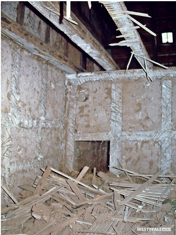
Bauernhaus Erfenbach vor Restaurierung - Innenräume (Edmund Jung, 1993)
