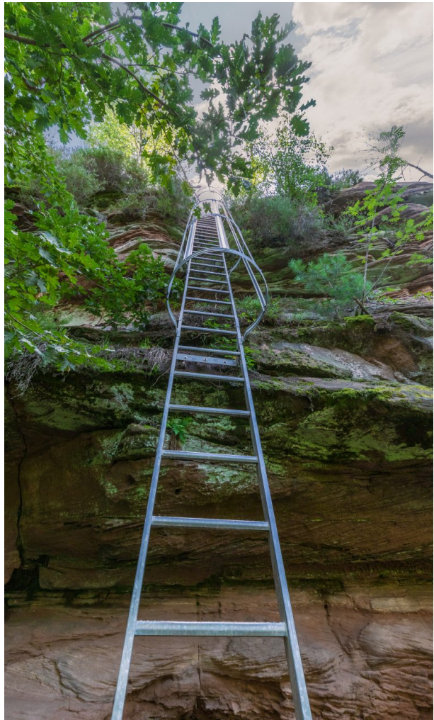
Leiter mit Absturzsicherung zur Aussichtsplattform des Hühnersteins (Harald Kröher, 2021)
