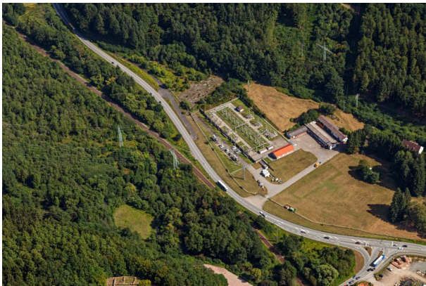
Luftaufnahme der Biebermühle und dem früheren Standort des Lagers (Harald Kröher, 2021)
