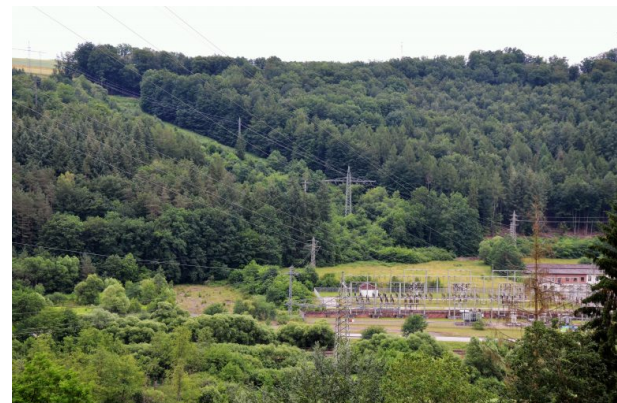
Blick auf einen Teil der früheren Lagerfläche. Heute sind die Pfalzwerke hier ansässig. Betonierte Bodenplatten am Rand des Geländes dürften noch aus der früheren Lagerzeit stammen. (Dr. Hans-Günther Clev , 2021)
