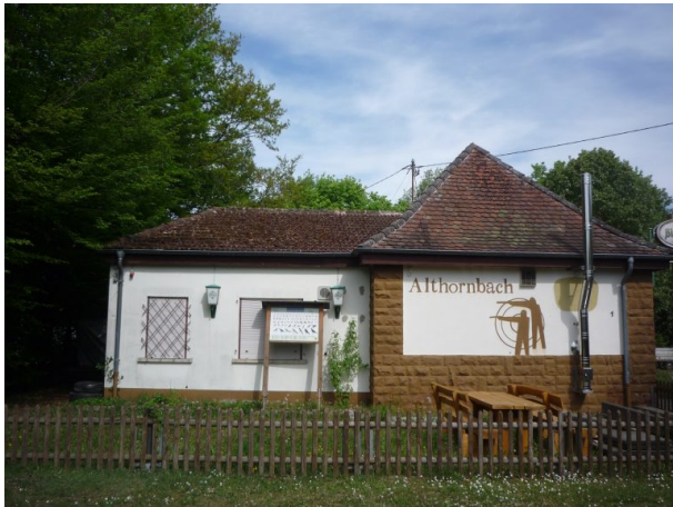
Frontalansicht auf das Gebäude (Reiner Schruft, unbekannt)
