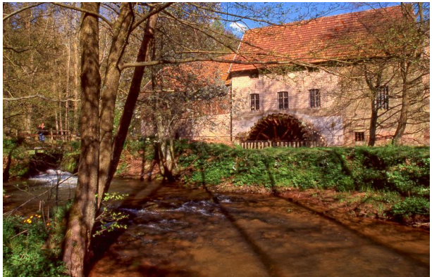
Außenansicht der Rosselmühle bei Thaleischweiler-Fröschen (Bernd Wagner, 2018)
